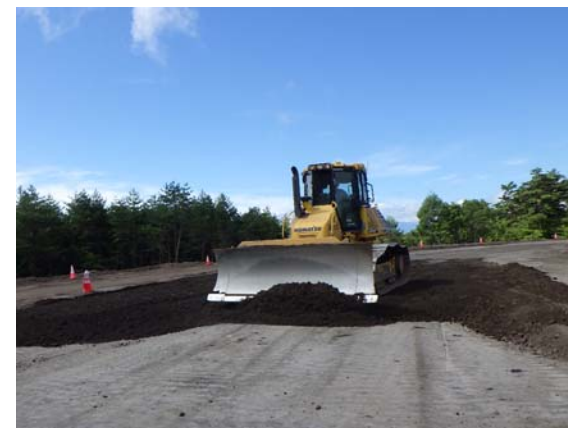
ソイルセメント敷均し・転圧
